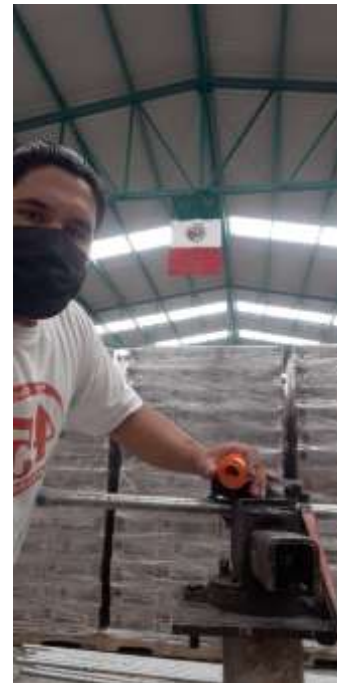
Ilustración 25 sacándole cuerda a la tubería para instalar
