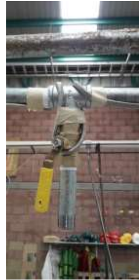
Ilustración 22 instalando válvula con resistencia o traza
