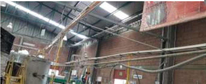
Ilustración 7 identificando el área de instalación
